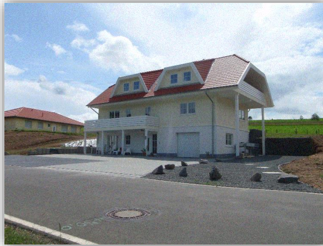
Außenansicht Apartment Wiese
